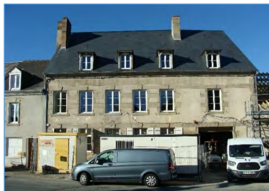
Future MSP en travaux
