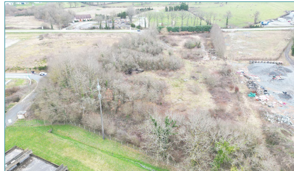
Vue d'ensemble prise par drone depuis le Nord du site - ©CAMPUS
