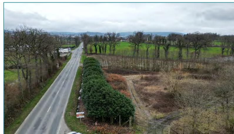
Entrée actuelle du site le long de la RD 940 - ©CAMPUS
